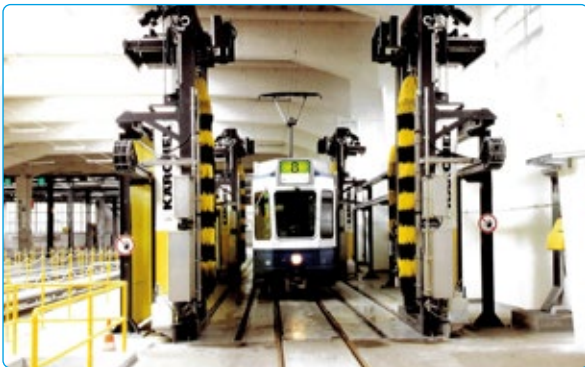
Tramwaschanlage in Zürich Station de lavage pour trams à Zurich
